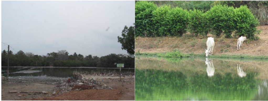
Figura 1-11. Lagunas de Oxidación en San Onofre con a) presencia de residuos sólidos y b) ganado vacuno en sus alrededores. Fotos: Ostin Garcés.
